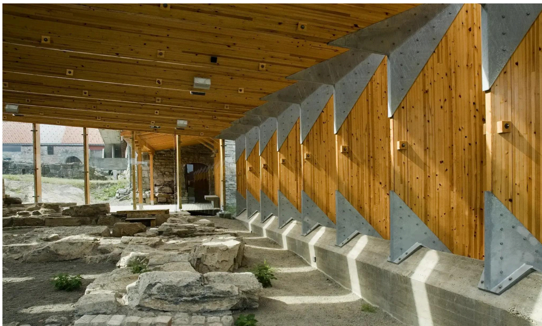
Figura 56 – Pilares em “V”
