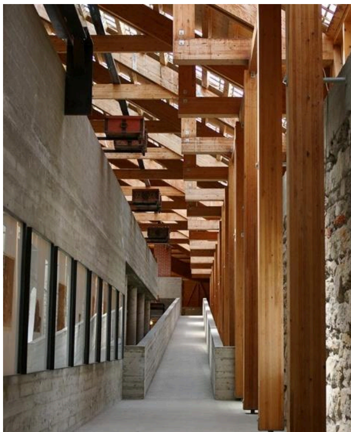
Figura 36 - Novo suporte para o telhado
