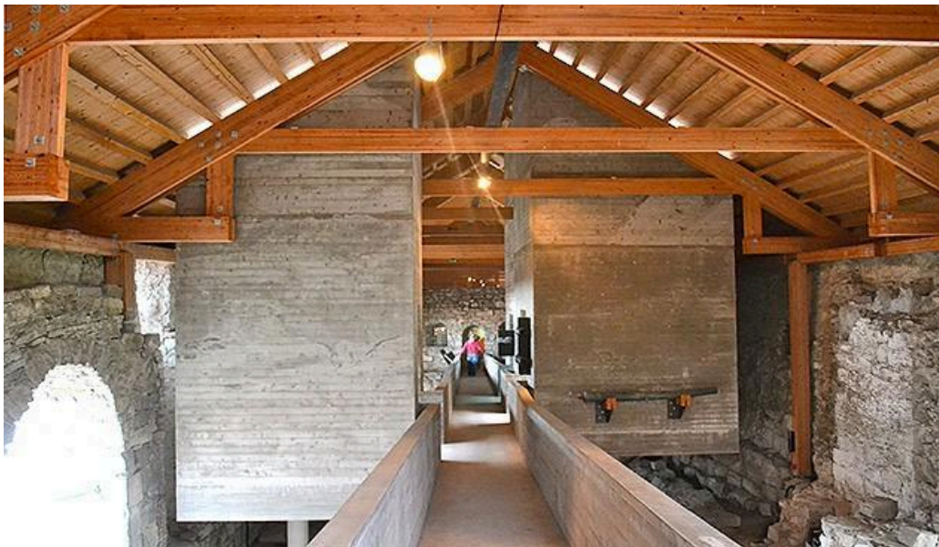
Figura 35 - Estrutura do telhado
