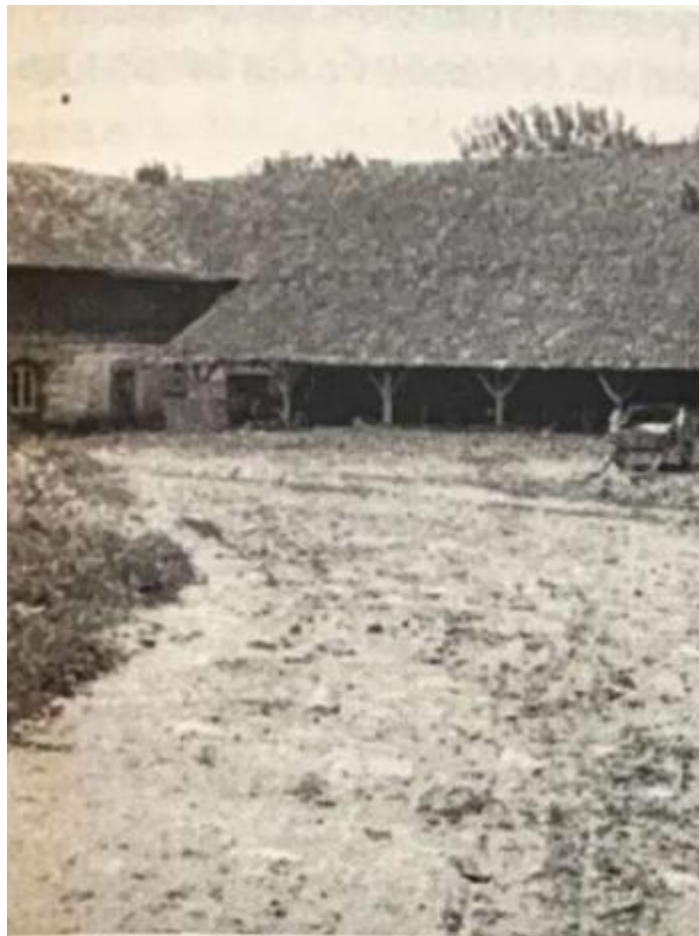
Figura 34 - A cobertura antiga
