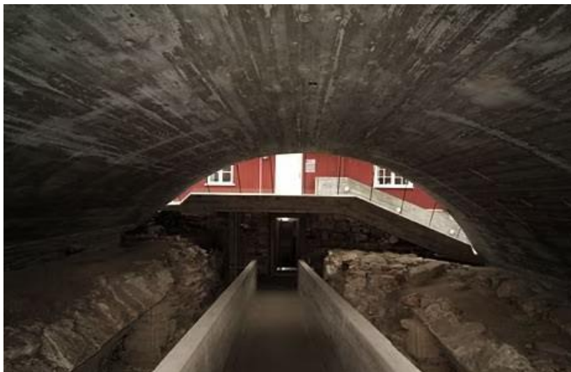
Figura 59 - Interior da Ruína de umas das Torres
